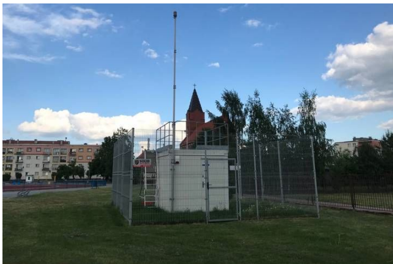
rys. 14. Automatyczna stacja pomiarowa jakości powietrza w Elku
