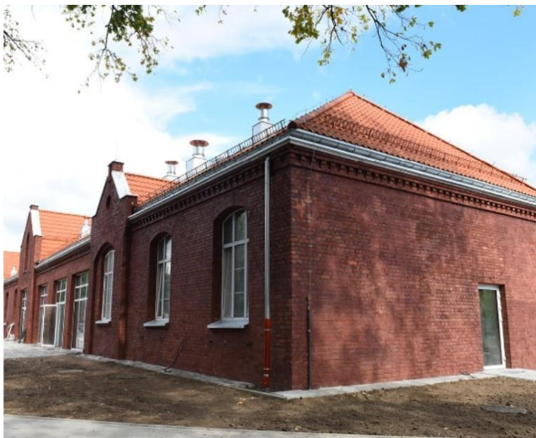
Rysunek 3 Budynek przy ul. Kościuszki 27A – siedziba Ełckiego Centrum Rewitalizacji Społecznej (źródło: Urząd Miasta Ełku).
