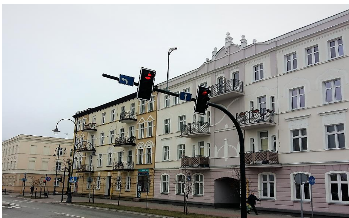
Widok na zmodernizowane budynki przy ul. Mickiewicza 22, 24 i 26
