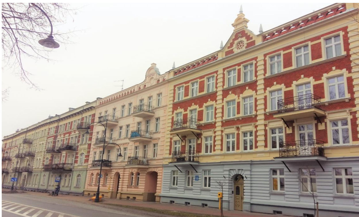
Widok na zmodernizowane budynki przy ul. Mickiewicza 14, 16 i 18
