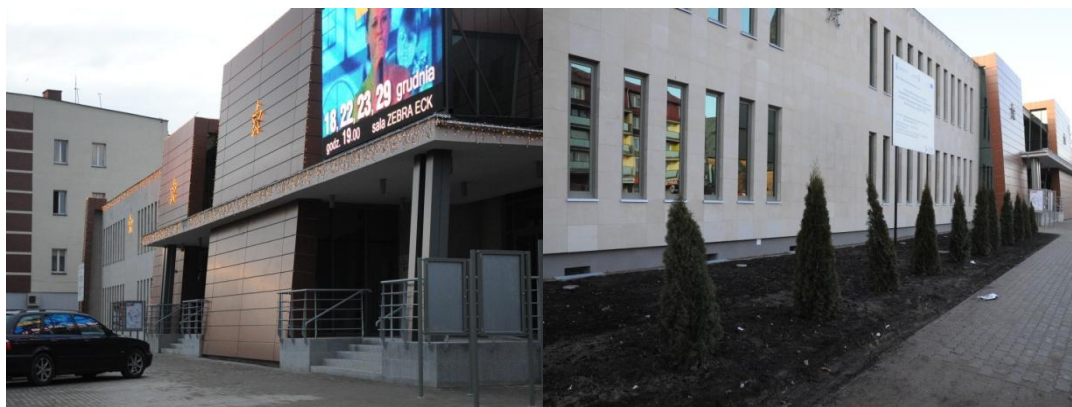
Budynek Ełckiego Centrum Kultury, Fot. ECK
