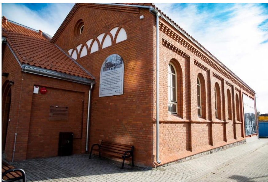
Zdjęcie 3. Budynek dawnej hali sportowej przy ul. Armii Krajowej po przebudowie (źródło: materiały własne)
