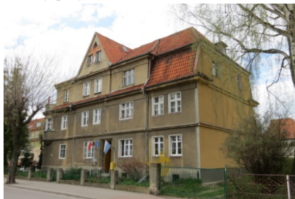
Budynek mieszkalny przy ul. Moniuszki 5
