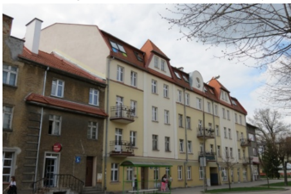
Ryc. 13. Budynek mieszkalny, ul. Gdańska 7/9
