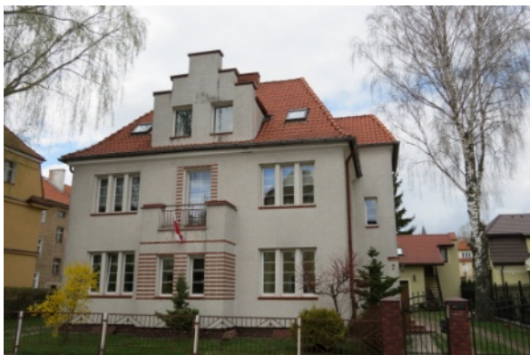
Budynek mieszkalny przy ul. Moniuszki 7
