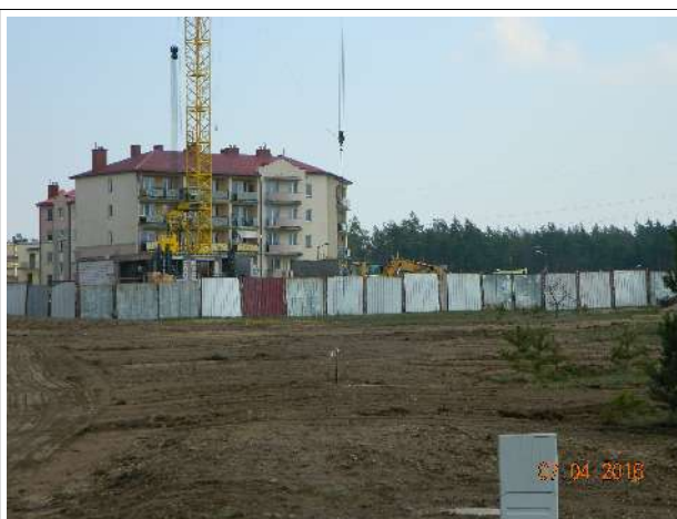
Teren budowy (zabudowa mieszkaniowa wielorodzinna) zlokalizowany na dz. nr 3902/19, ul. św. MM. Kolbe
