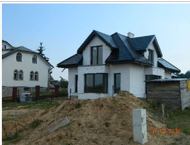
Budynek mieszkalny jednorodzinny w trakcie budowy, zlokalizowany na dz. nr 3899/4, ul. Spacerowa
