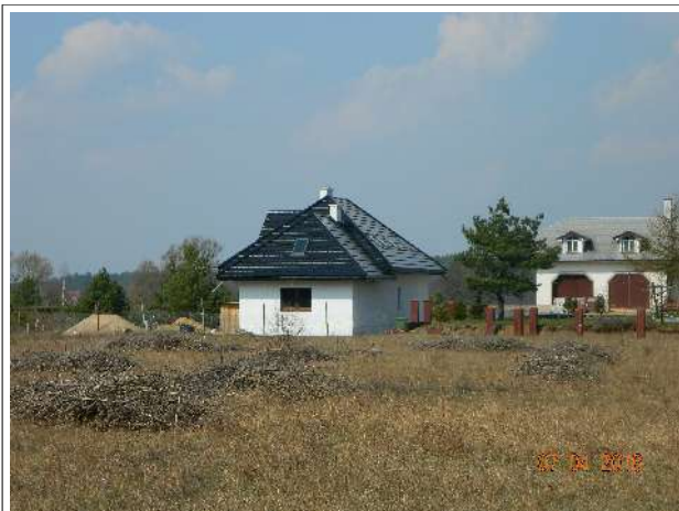
Budynek mieszkalny jednorodzinny w trakcie budowy, zlokalizowany na dz. nr 3899/4, ul. Spacerowa
