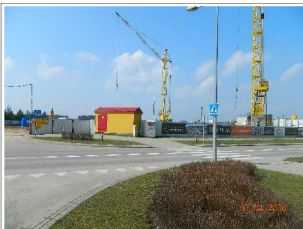
Teren budowy (zabudowa mieszkaniowa wielorodzinna) zlokalizowany na dz. nr 3902/19, ul. św. MM. Kolbe
