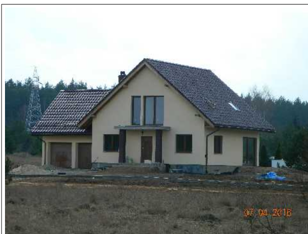
Budynek mieszkalny jednorodzinny w trakcie budowy, zlokalizowany na dz. nr 3700/2, ul. Baranki
