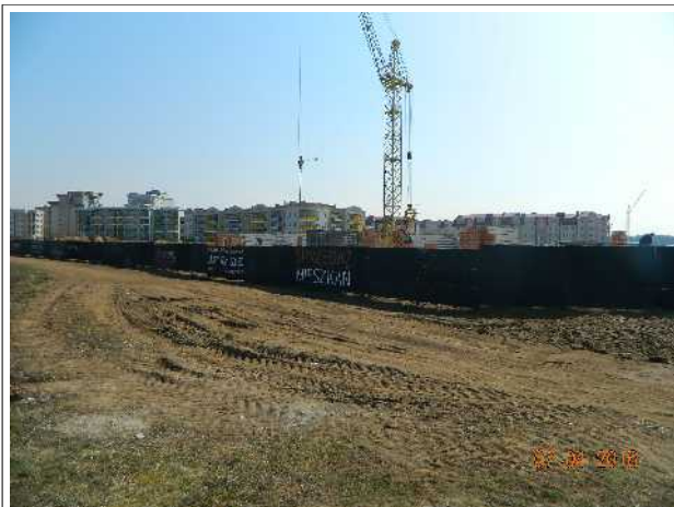
Teren budowy (zabudowa mieszkaniowa wielorodzinna) zlokalizowany na dz. nr 3903, 3827/66 i 3827/85, ul. św. MM. Kolbe
