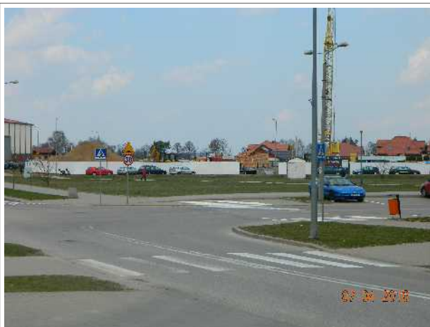
Teren budowy (zabudowa mieszkaniowa wielorodzinna) zlokalizowany na dz. nr 3903, 3827/66 i 3827/85, ul. św. MM. Kolbe
