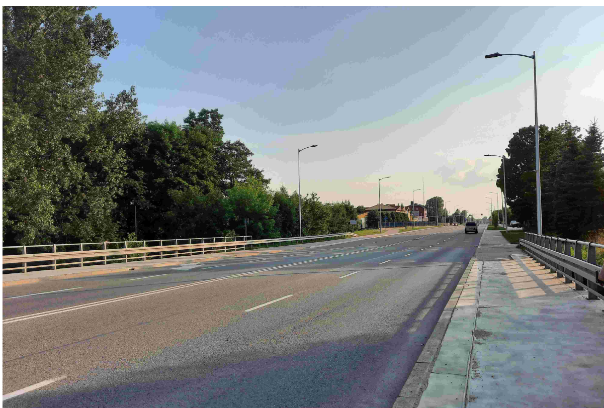
Rys. 2.7. Widok na południową granicę opracowania (ulica Suwalska) (źródło: fotografia własna)
