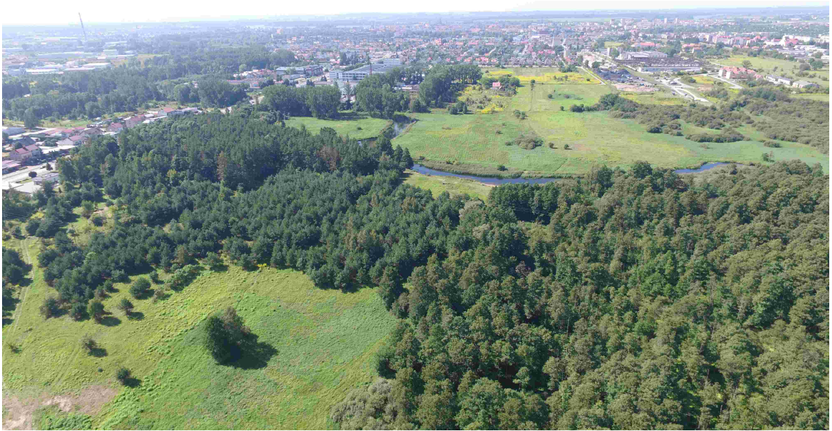
Rys. 2.3. Widok od strony wschodniej na teren opracowania (rzeka Elka, następnie tereny zielone) (źródło: UM Elk)
