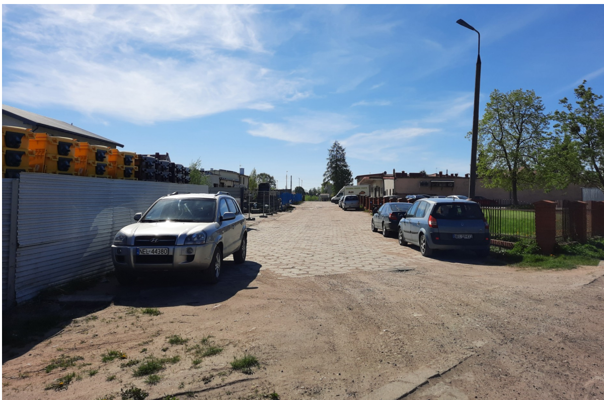
Rys. 2.4. Widok na obszar opracowania od strony zachodniej (od ul. Kolonia i drogi wewnętrznej) (źródło: fotografia własna)
