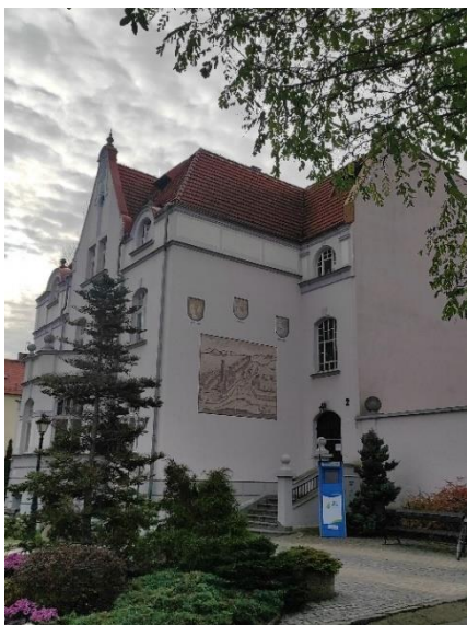
Kamienica przy ul. Piłsudskiego 2
