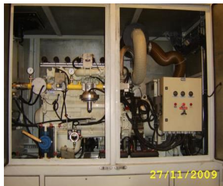
Zdj. 4 i 5. Instalacja do energetycznego wykorzystania biogazu z oczyszczalni ścieków PWiK w Etku
