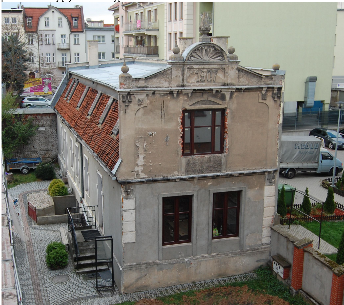
Widok ściany frontowej i szczytowej z E na W
