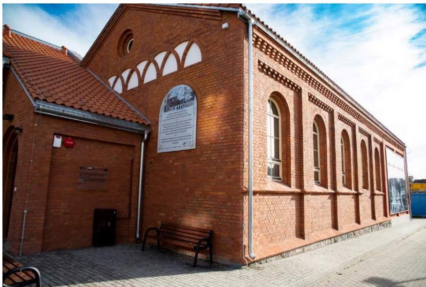
Zdjęcie 3. Budynek dawnej hali sportowej przy ul. Armii Krajowej 16 po przebudowie (źródło: materiały własne)
