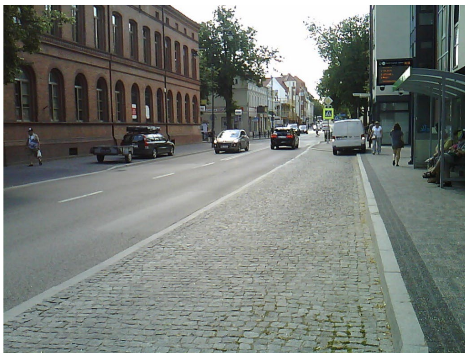
Rysunek 17. ul. Armii Krajowej 11a w rejonie przystanku autobusowego
