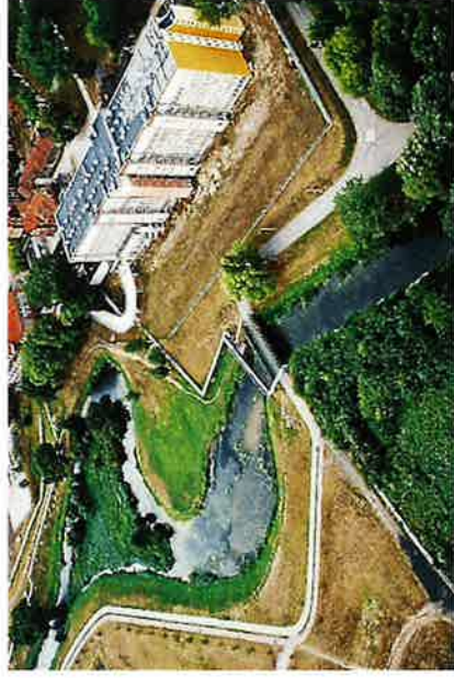
Ryc. 6. Rzeka Elka, stanowiąca wody powierzchniowe terenu opracowania
