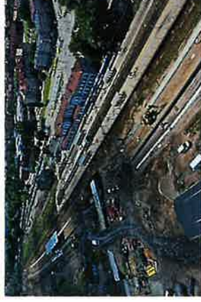
Ryc. 21. Modernizacja linii kolejowej Elk w ramach Rail Baltica
