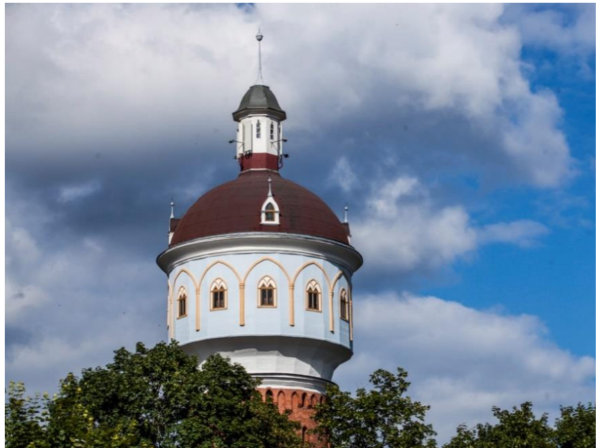
Wieża Ciśnień fot. Urząd Miasta Ełku
