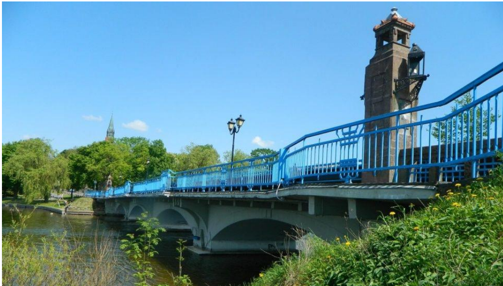
Most drogowy na ul. Zamkowej, fot. Urząd Miasta Elku
