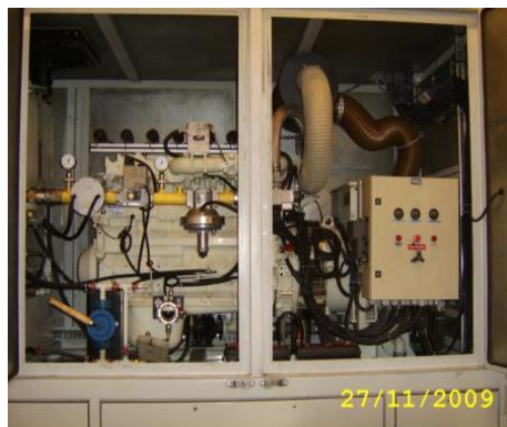
Zdj. 4 i 5. Instalacja do energetycznego wykorzystania biogazu z oczyszczalni ścieków PWiK w Etku
