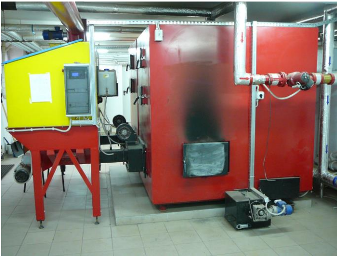
Zdj. 11 i 12. Instalacja 2 kotłów na biomasę w Zespole Szkół Samorządowych.
