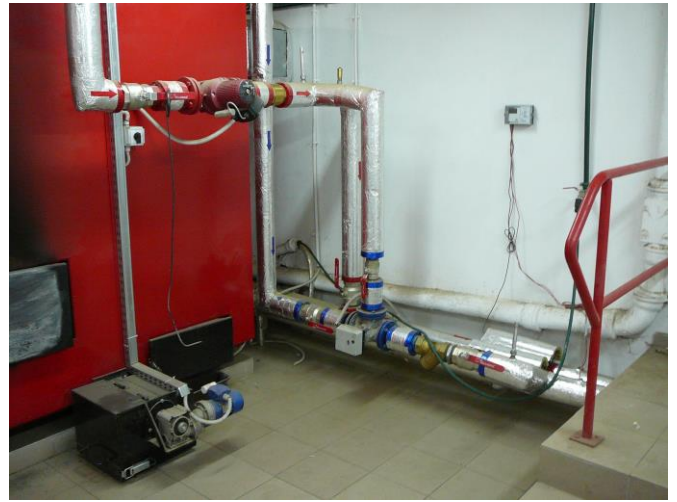
Zdj. 11 i 12. Instalacja 2 kotłów na biomasę w Zespole Szkół Samorządowych.
