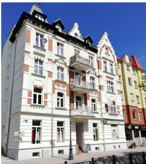
Rysunek 5 Przykłady modernizacji budynków wielorodzinnych w Śródmieściu Ełku w 2018 r. (fot. Urząd Miasta Ełku).
