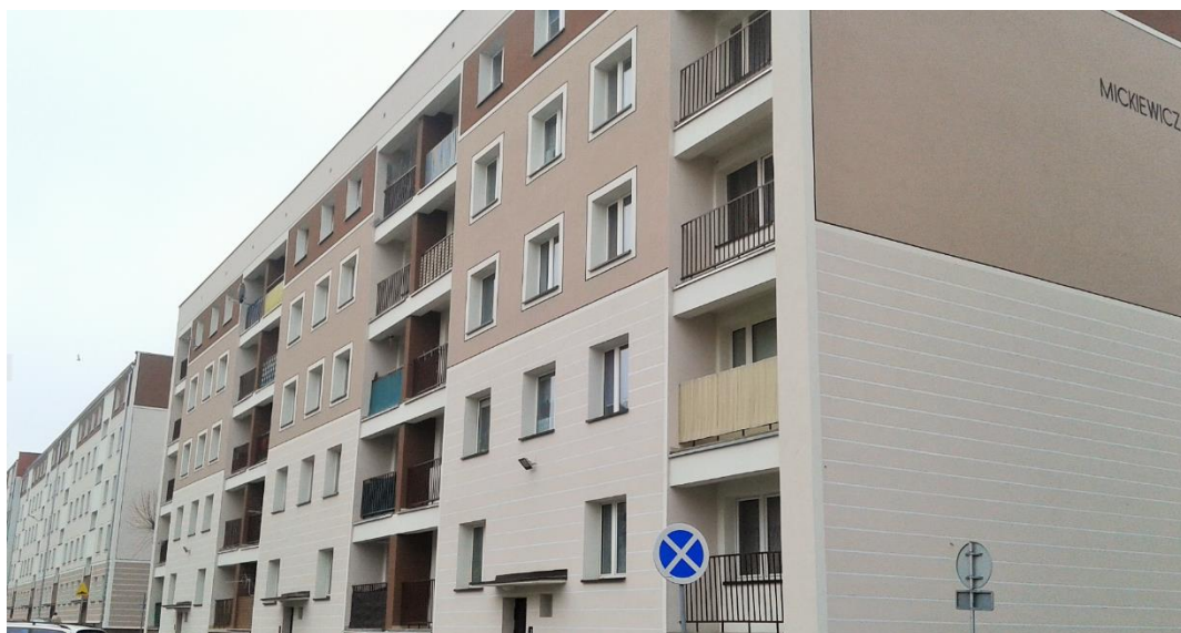
Budynki przy ul. Mickiewicza 4, 6, 8
