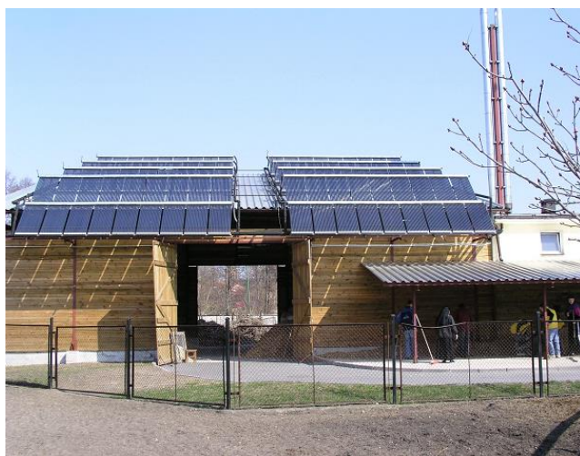
Zdj. 6 i 7. Instalacja solarna i kotłownia na biomasę w Domu Pomocy Społecznej „Tęczowy Dom” (Źródło zdjęć i informacji: Starostwo Powiatowe w Elku)
