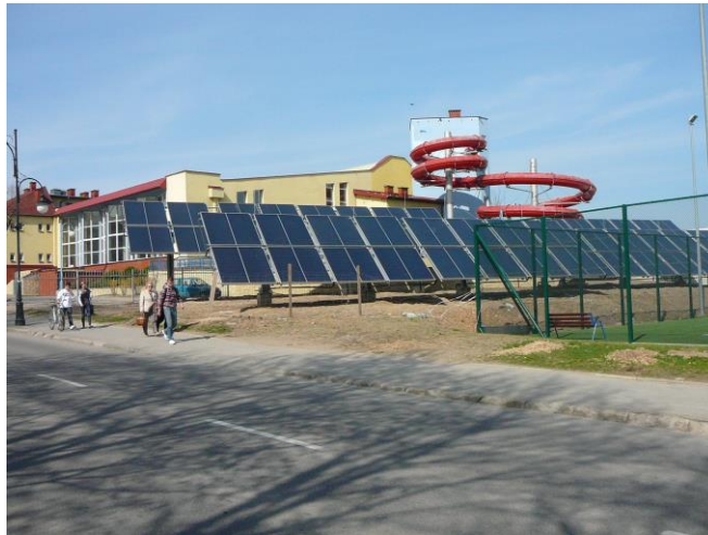
Zdj. 9 i 10. Instalacja kolektorów fotowoltaicznych oraz słonecznych w Parku Wodnym.
