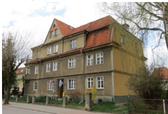
Budynek mieszkalny przy ul. Moniuszki 5
