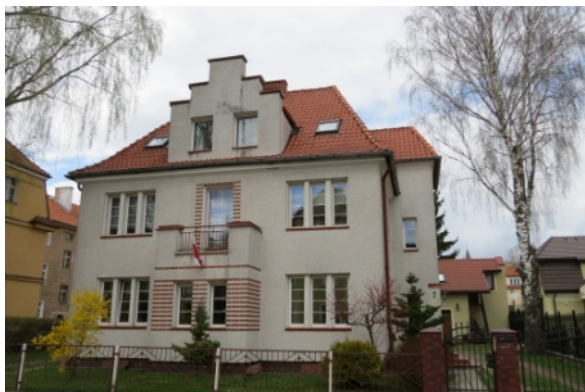
Budynek mieszkalny przy ul. Moniuszki 7
