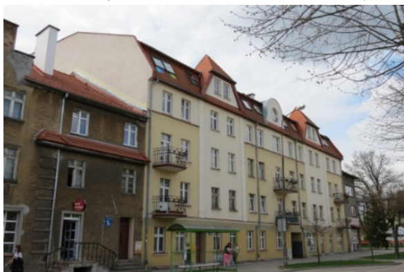
Ryc. 13. Budynek mieszkalny, ul. Gdańska 7/9
